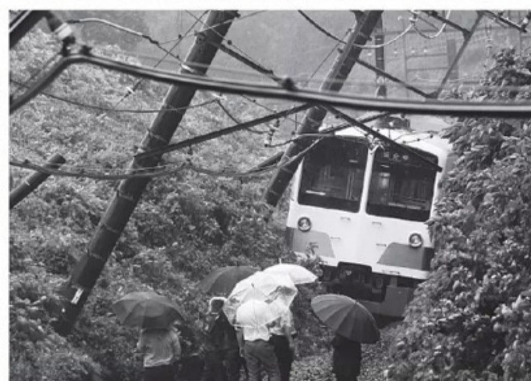
台風9号の豪雨によって線路脇の斜面が崩れた西武多摩湖線
