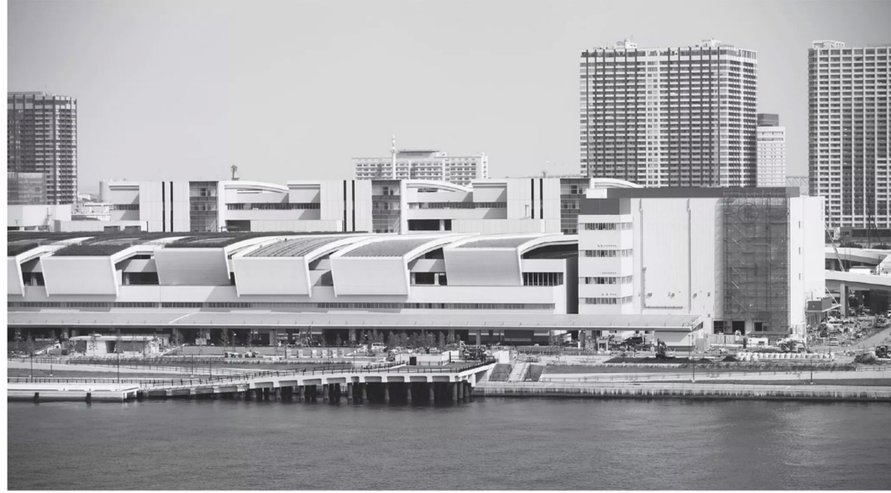
当初の見込み、4316億円から5884億円に大きく膨らんだ豊洲新市場の総事業費。もし今後、建物の耐震性を改善する必要に迫られれば、さらに膨らむことも……
